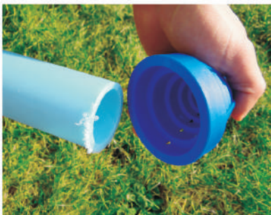
Rura przed fazowaniem A pipe before chamfering
